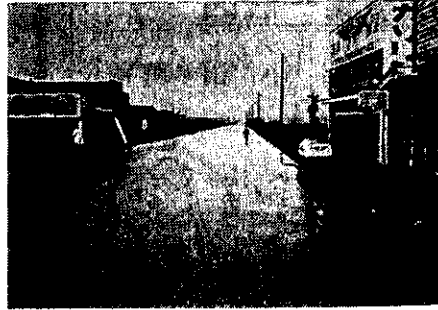
コンクリート舗装完成
