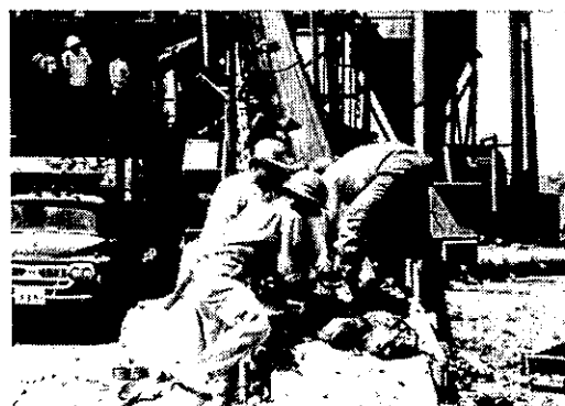
アスファルトプラントにおける混合作業
