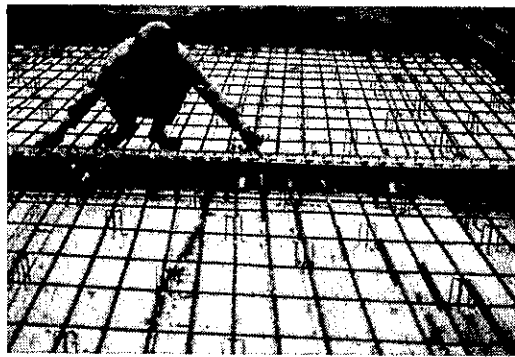
連続鉄筋コンクリート舗装の配筋
