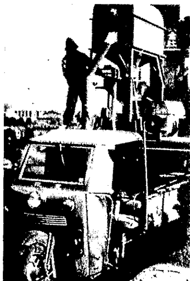
三輪トラックによるプラント設置
