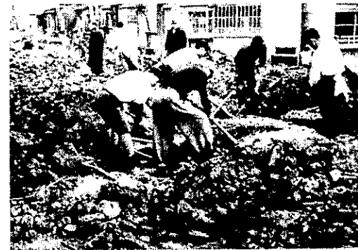
施工前の下田市内
