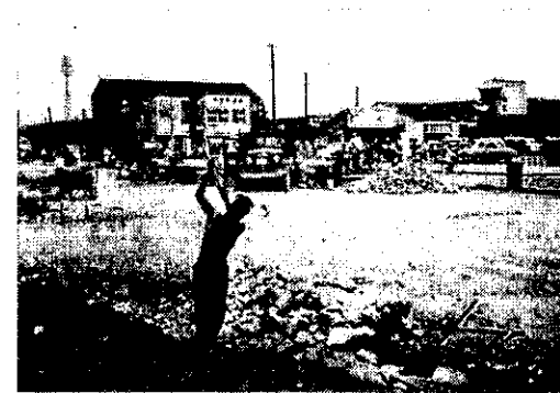
工事前の静岡駅前
