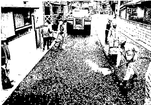
(県) 須崎柿崎線 下田市地内 (施工状況)
